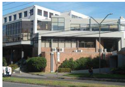
Fachada Vidriada Auditorio
